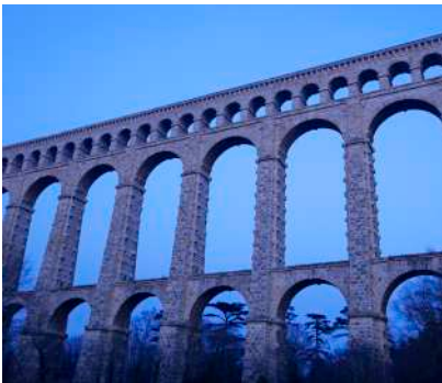
Ventabren, aqueduc de Roquefavour du XIX e siècle
